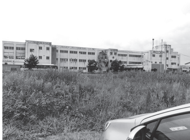
津波により廃校となった関上中学校
